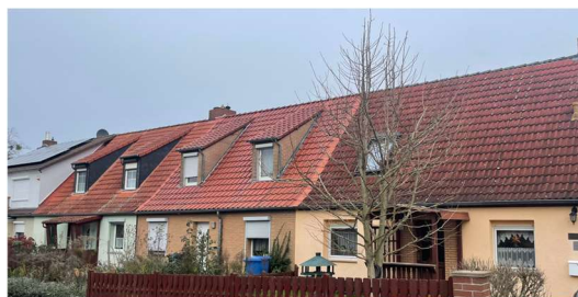
Abb. 6 Typische Dachlandschaft einer Reihenanlage in Büddenstedt
