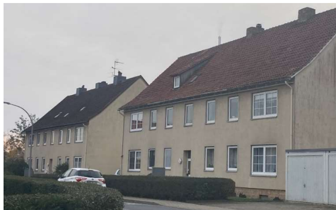
Abb. 15 Gestalterisch nicht ganz geglücktes Sanierungsbeispiel in Büddenstedt
