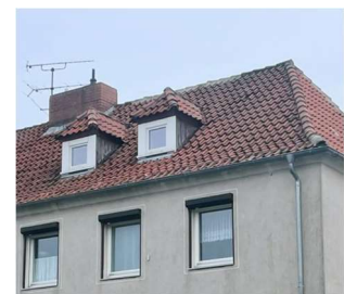
Abb. 7 Ursprüngliche Bedachung eines Mehrfamilienhauses in Büddenstedt
