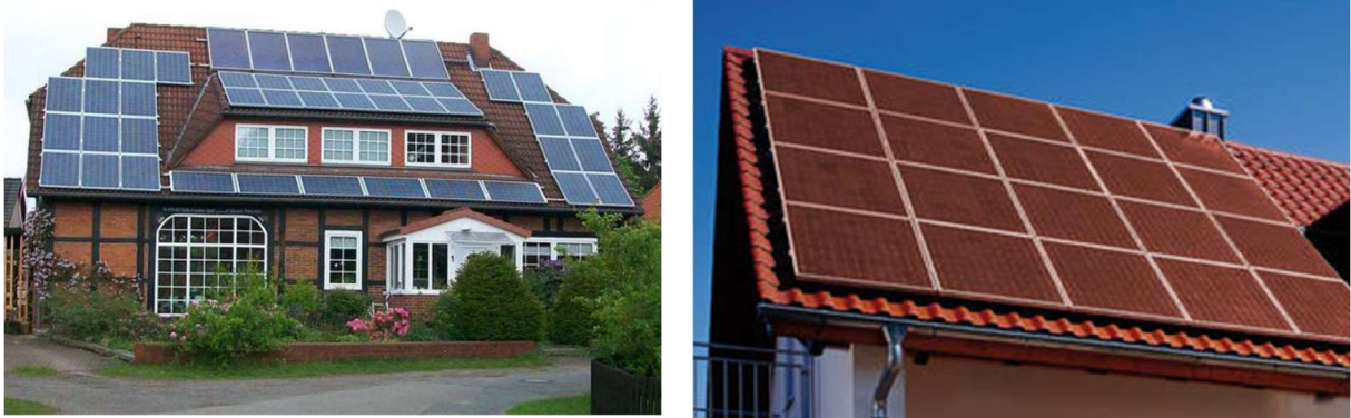
Abb. 20 Dach-PV-Anlagen Negativbeispiel (links): weder farblich noch funktional abgestimmte Anlage und Positivbeispiel (rechts): farblich angepasste Aufdach-Anlage mit ruhigem Gesamterscheinungsbild
