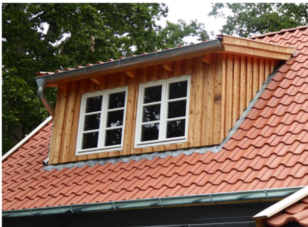
Abb. 11 Beispiele: Neue Dachgaube mit Fenstern und Holzverschalung, erneuerte Fachwerkfassade
