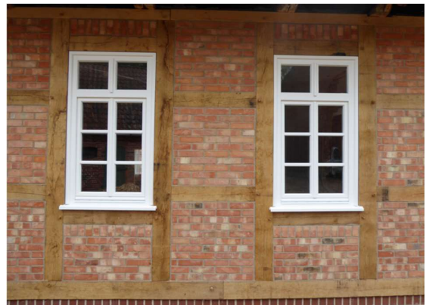
Abb. 11 Beispiele: Neue Dachgaube mit Fenstern und Holzverschalung, erneuerte Fachwerkfassade
