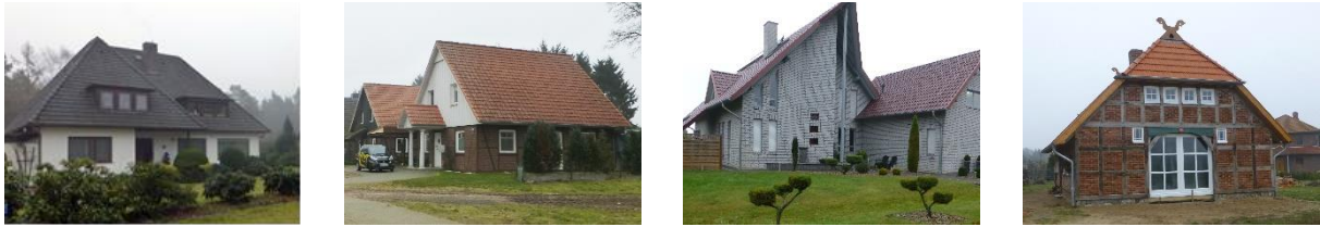
Abb. 42 Beispiele nichtförderfähiger Bausubstanz nach 1960 (Fotos außerhalb der Dorfregion)
